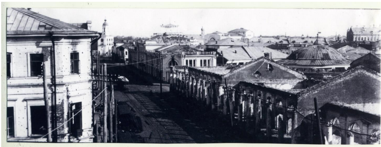
Разрушения в Ярославле после антибольшевистского восстания 6-21 июля 1918 г.
