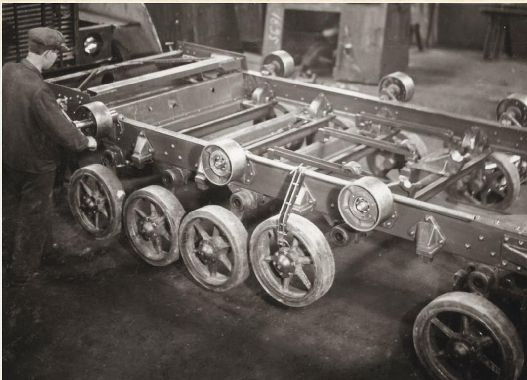
**120. Я-12 производства Ярославского государственного автомобильного завода. Шасси для автотягача с мотором «Джиэмси». 1943 г.**
