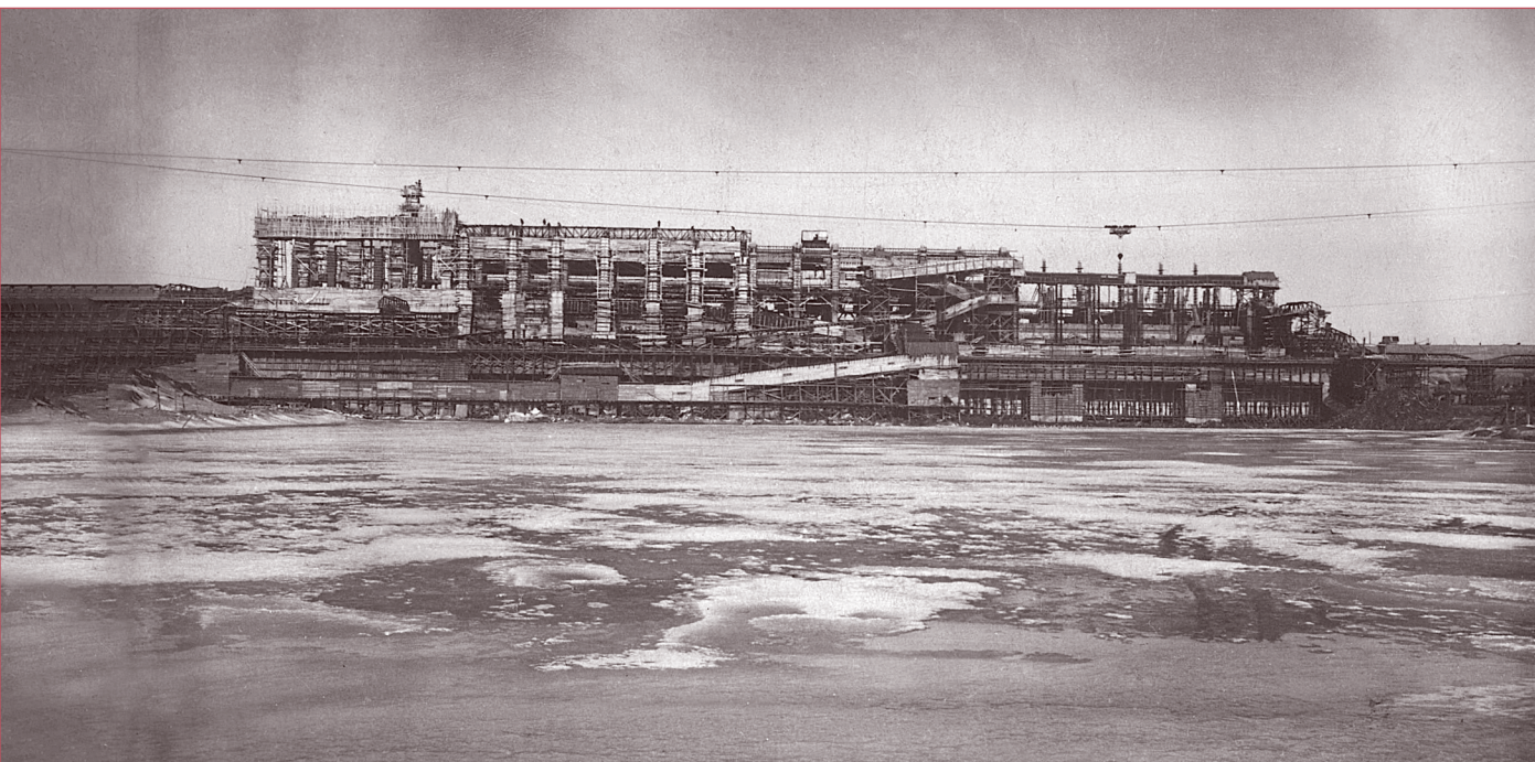
Вид ГЭС со стороны нижнего бьефа. Апрель 1941 г. РБФ ГАЯО. П1-1626
